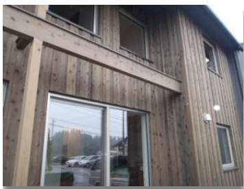
外壁材(南北面)杉板
