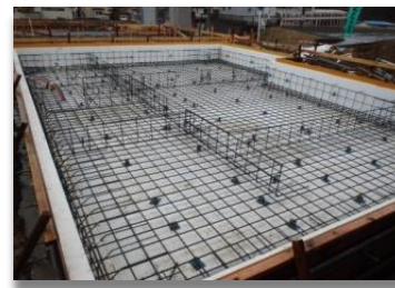
断熱材 (基礎) 基礎外 t 100 土間下 t
